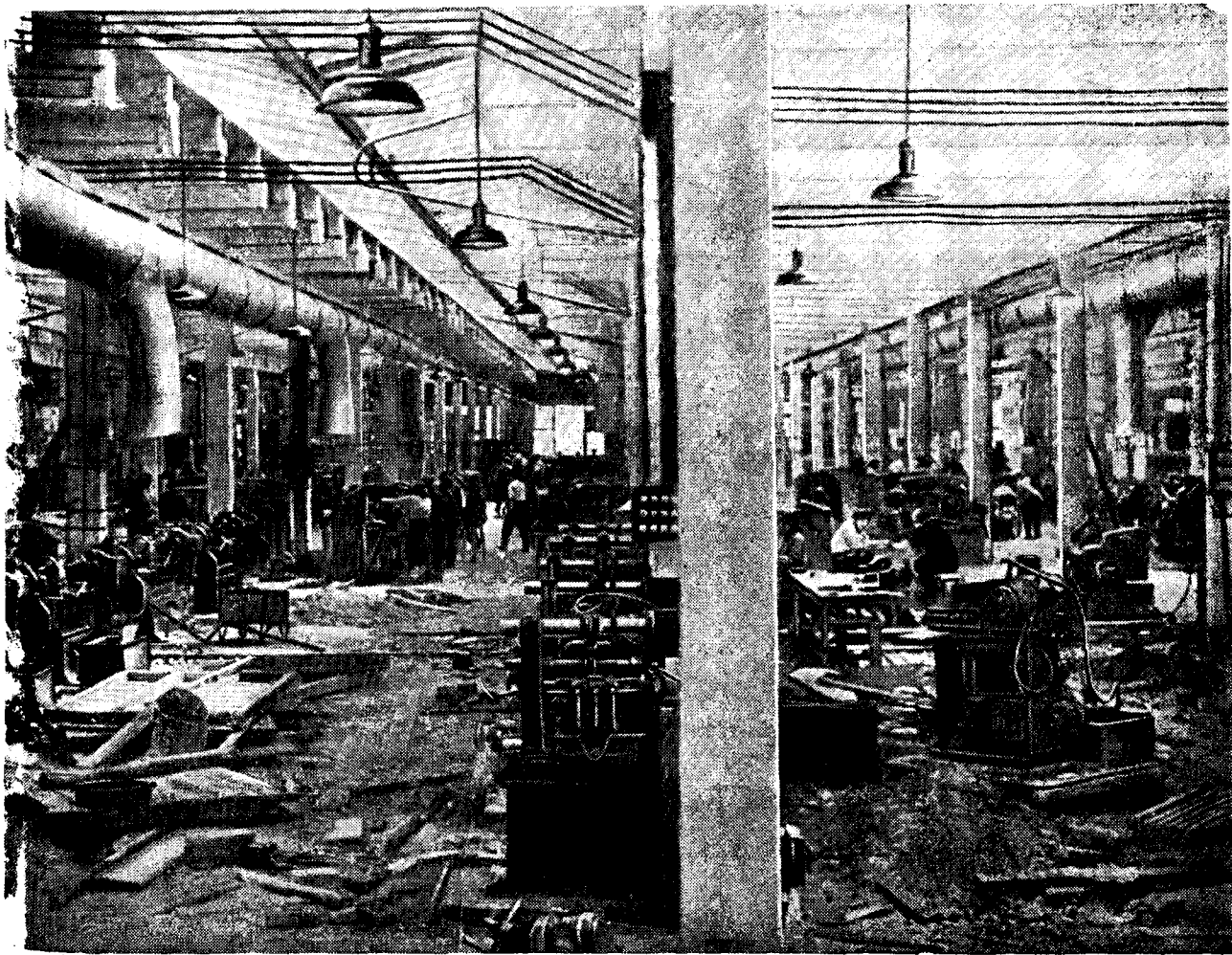
Монтаж оборудования в главном корпусе завода.
